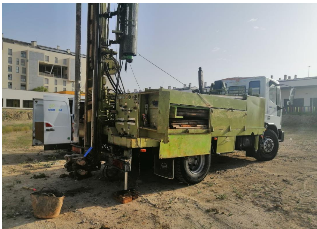
Figura Nº 8.- Imagen de la ejecución del sondeo mecánico y rotativo con extracción continua de testigo referido como S-01.
